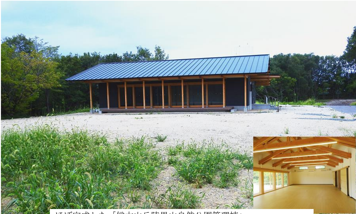
ほぼ完成した「信太山丘陵里山自然公園管理棟」
