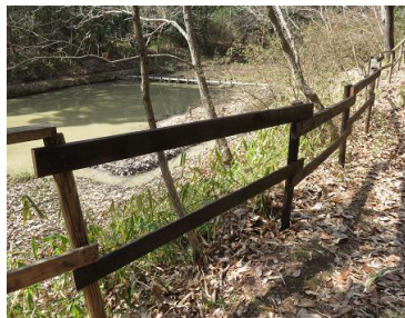
補修前と補修後
