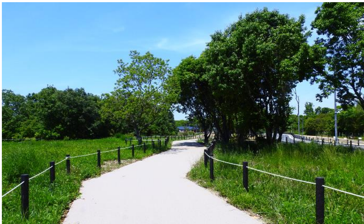
公園西エリア草原に整備された遊歩道とその先に建設されている管理棟 2023.05
