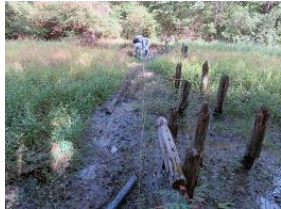
4号木道：施工前
