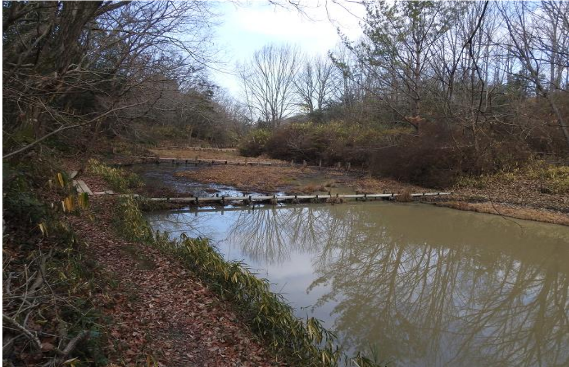
木道の付け替え工事が終わった惣ヶ池湿地
