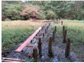
3号木道：施工前
